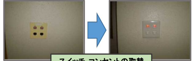
スイッチ、コンセントの取替
