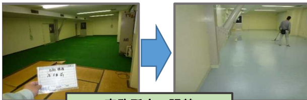
事務所床の張替
