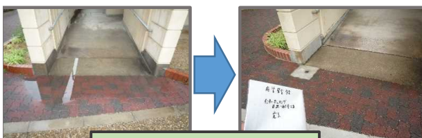
水溜り解消(排水口設置)
