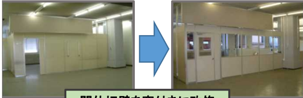
間仕切壁を窓付きに改修
