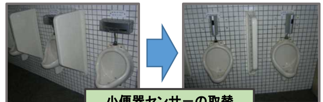
小便器センサーの取替
