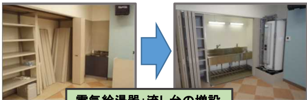
電気給湯器+流し台の増設
