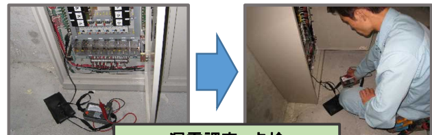
漏電調査、点検
