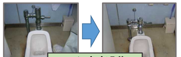
フラッシュバルブの取替
