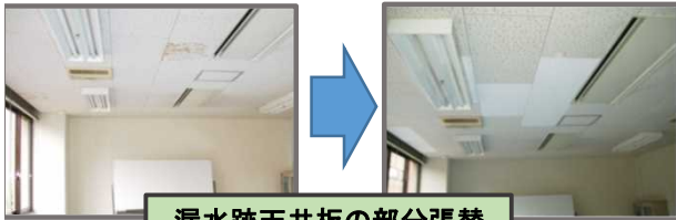
漏水跡天井板の部分張替
