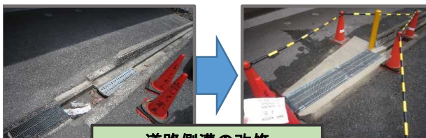
道路側溝の改修
